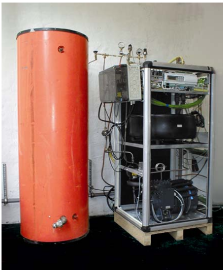
Bild 1: Luft/Wasser Wärmepumpe in Splitausführung Innengerät mit Speicher
